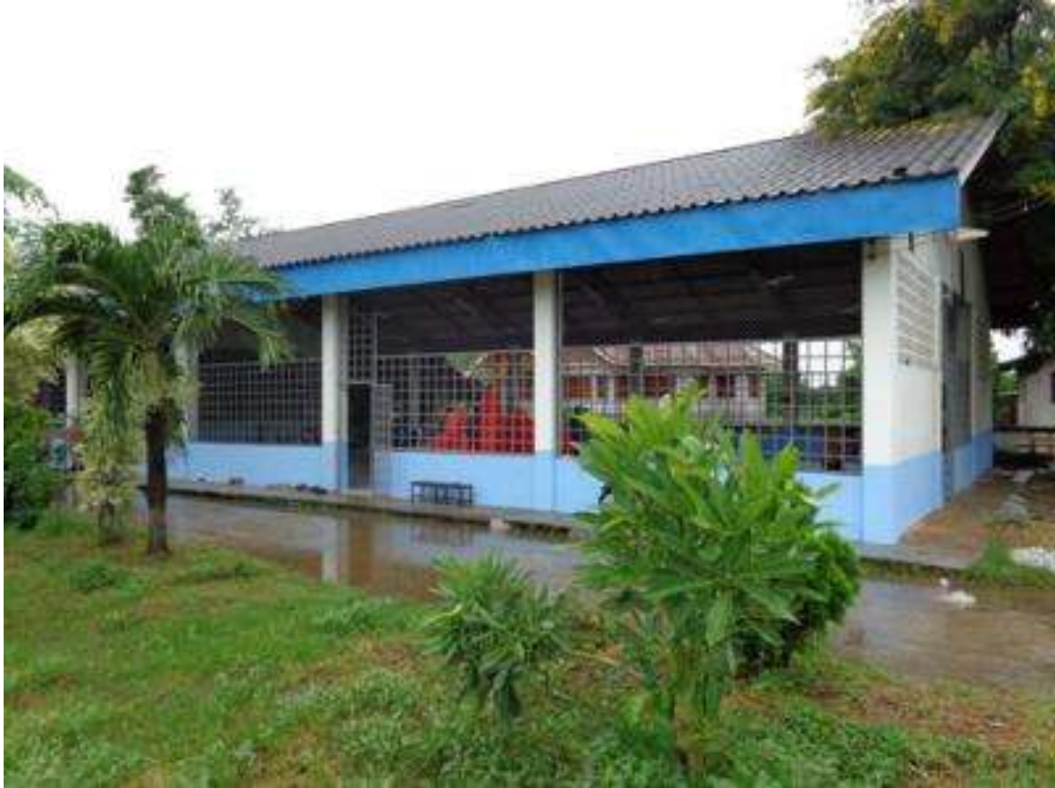
5.อาคารอเนกประสงค์/โรงอาหาร/โรงฝึกงาน/หอประชุมอื่น(สร้างเอง) ปีที่สร้าง 2543
