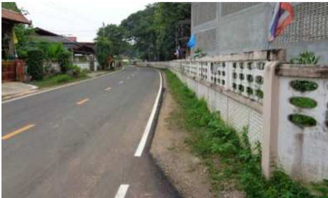
14. กำแพงคอนกรีตเสริมเหล็ก,พร้อมซุ้มประตู 3 ซุ้ม (ศิษย์เก่า สร้างเอง)
